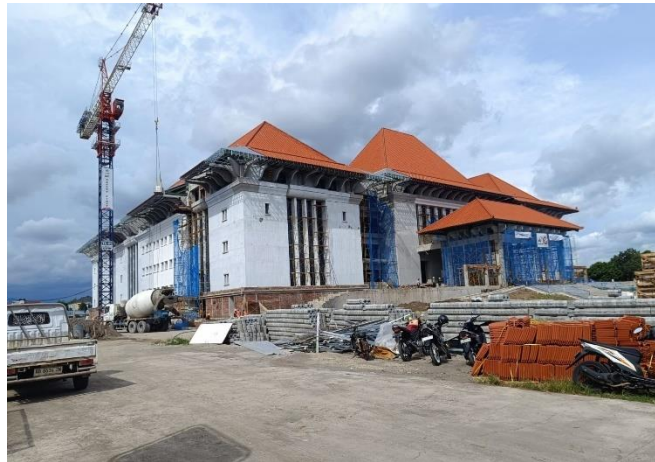
Gambar III. 3 Pembangunan Gedung DPRD DIY
